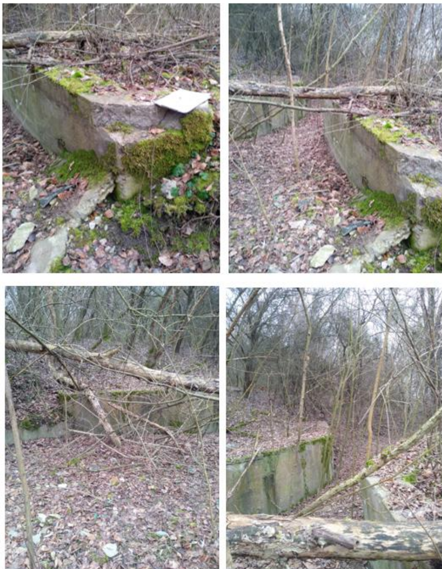
Obrázek 42 – Fotografie stavebních objektů – nátokové žlaby
