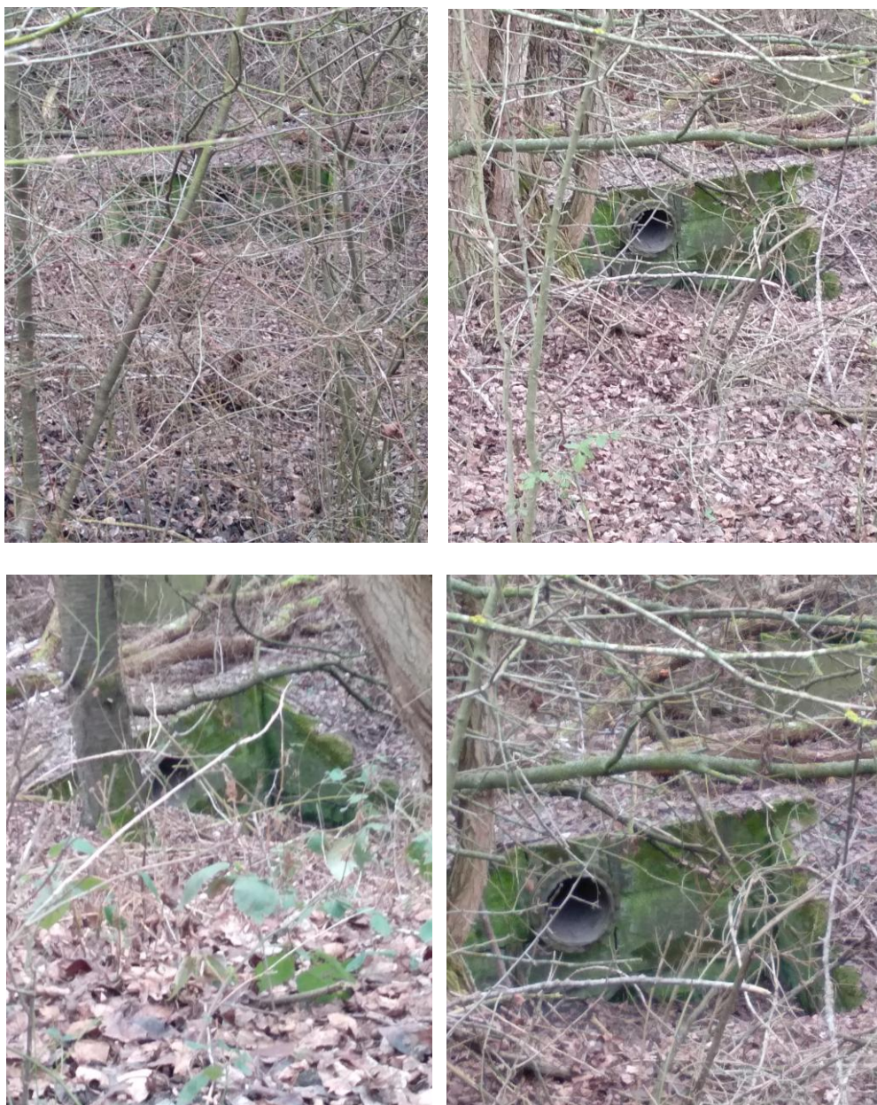
Obrázek 43 – Fotografie stavebních objektů – stěny propustku
