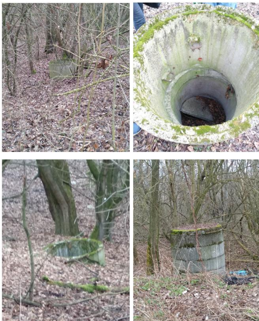
Obrázek 40 – Fotografie stavebních objektů – revizní šachty
